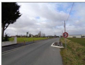
Figure 5 : Rétrécissement de la chaussée
