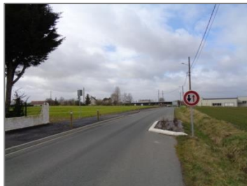
Figure 5 : Rétrécissement de la chaussée
