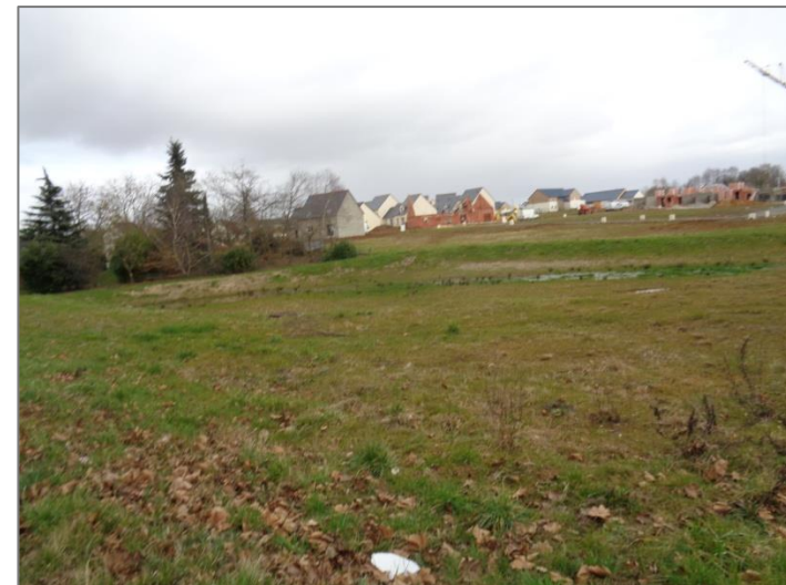
Figure 19 : Bassin de rétention
