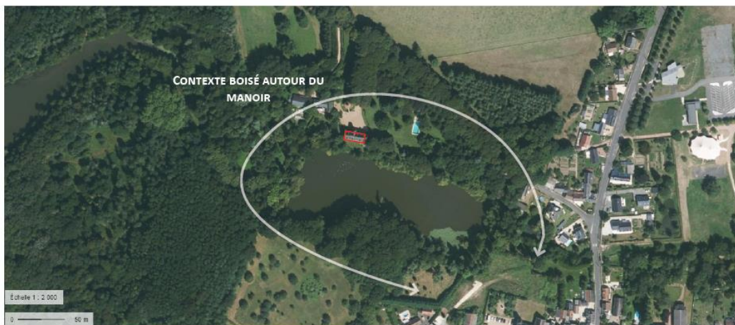
Figure 72. Insertion du château dans son environnement (source : Géoportail)
